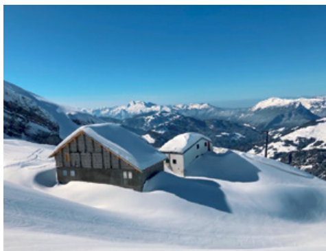
Vers la fin des travaux ! ©FFCAM
